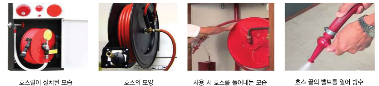
호스릴이 설치된 모습 호스의 모양 사용 시 호스를 풀어내는 모습 호스 끝의 밸브를 열어 방수
